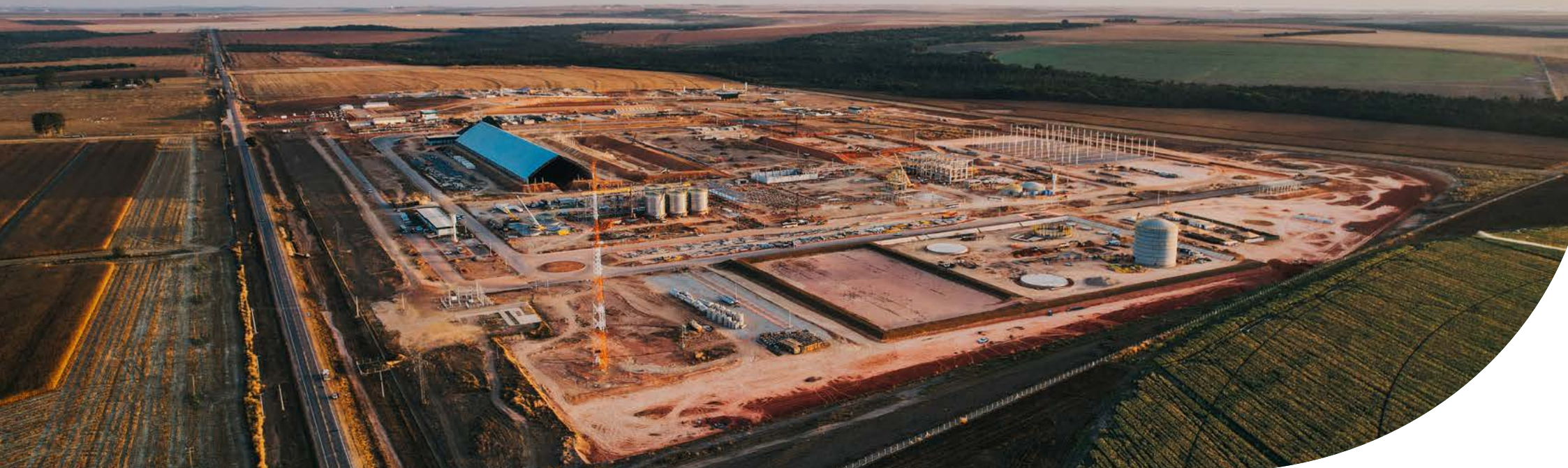
Unidade de Primavera do Leste, Mato Grosso, em construção
